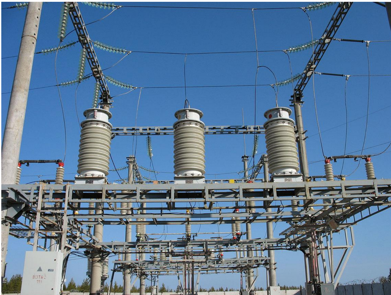
Трансформаторы напряжения 110 кВ
